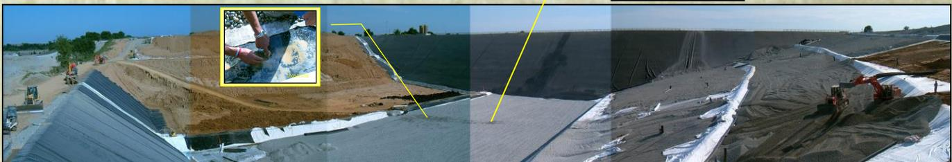
**Il collaudo elettrico OHMEX permette di localizzare le lesioni del telo impermeabilizzante grazie allo studio della forma che il campo elettrico, appropriatamente creato, assume in prossimità di esse.**
